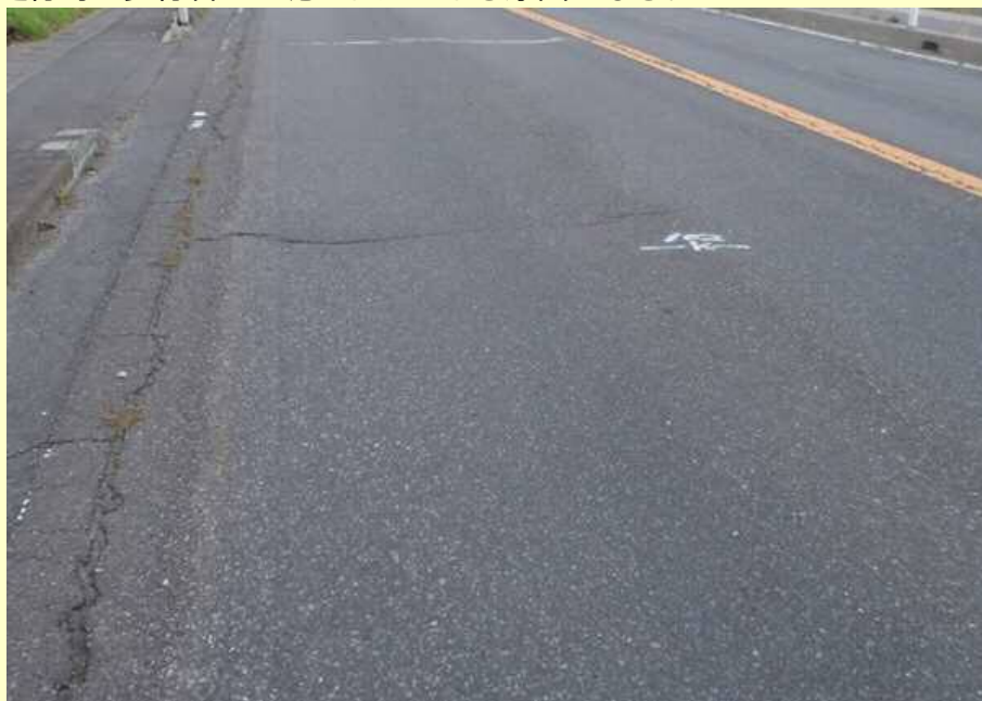
図-2.4 わだち掘れ損傷イメージ
