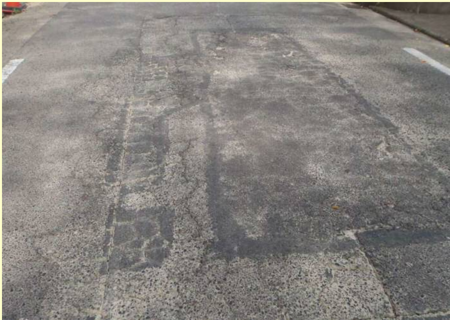
図-2.5 平たん性(IRI)損傷イメージ
