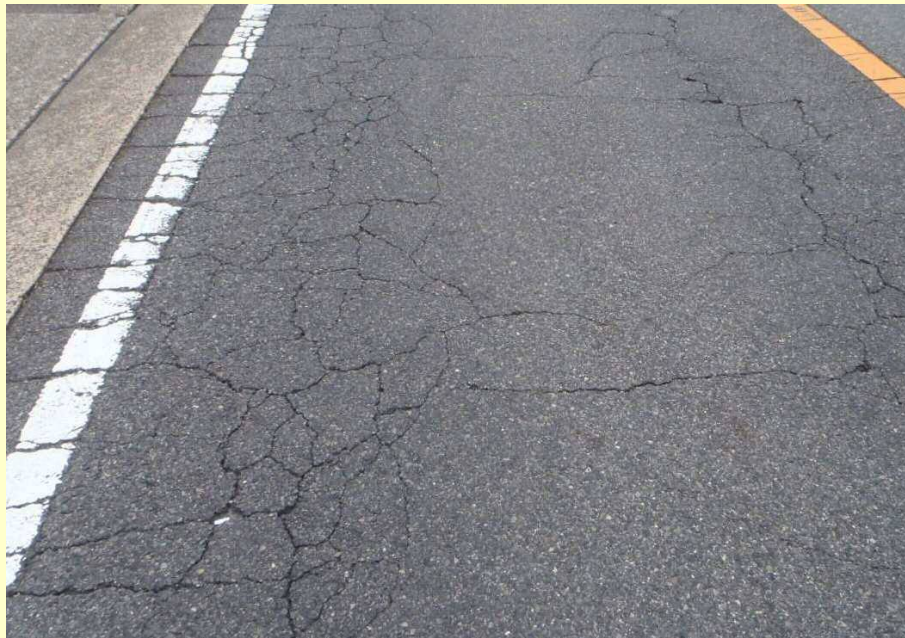
図-2.3 ひび割れ損傷イメージ
