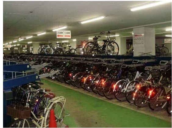
<地下施設の整備事例>
