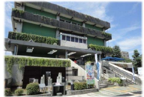
名城水処理センター
