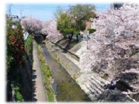
日岡橋～大島七号橋
