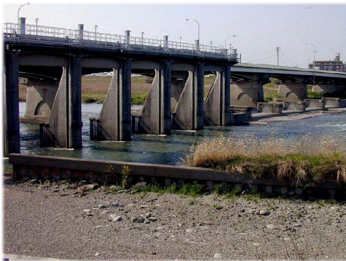
庄内用水頭首工
