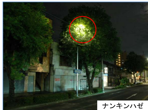
道路照明を隠している街路樹
