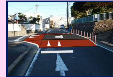
交差点ハンプ設置
