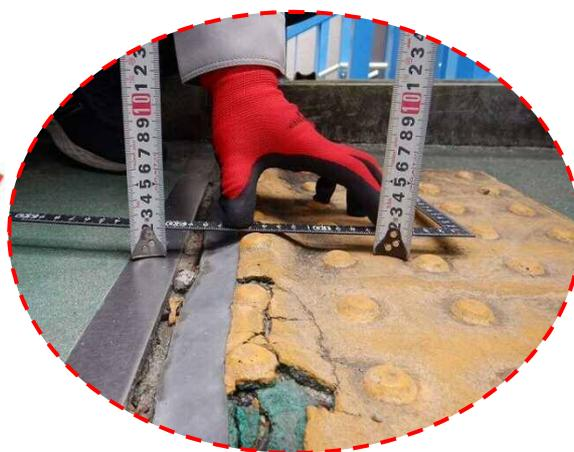
◇ 横断歩道橋の舗装も、経年変化により、ひび割れや段差が発生します。
