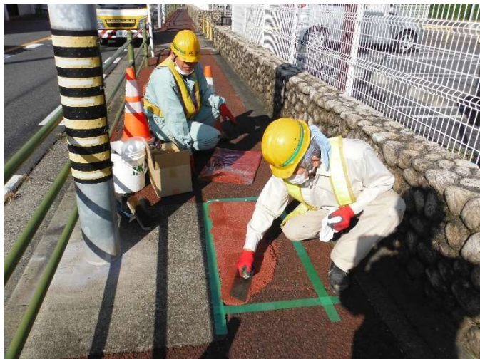
歩道上の段差を解消しています。
