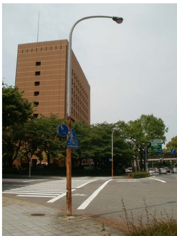
(設置に適切でないとする街路灯の例) 錆がひどく設置が困難な事例
