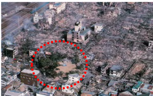
■焼け止まりとなった大国公園（神戸市）
