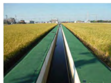
■水路の寿命を延ばす補修（港区）
