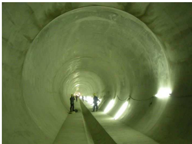
写真-4.9 雨水滞水池の建設（初期雨水を一時的に貯留する施設）
