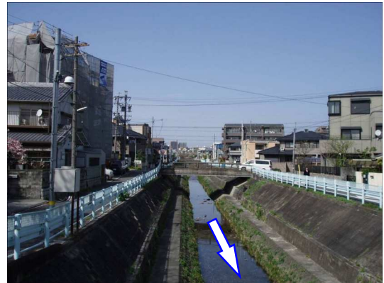
写真-1.2 上流部鵜(ひさご)橋付近 (河口から約10.1km)
