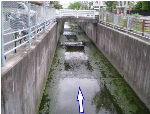
写真-1.1 上流部三面張区間 (河口から約12.0km)
