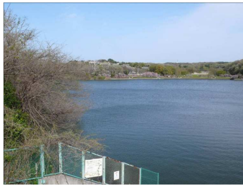
写真-2.6 猫ヶ洞池
