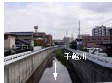
写真－ 6 手越川 ( くるまみち 車路橋 0.1km 付近)
