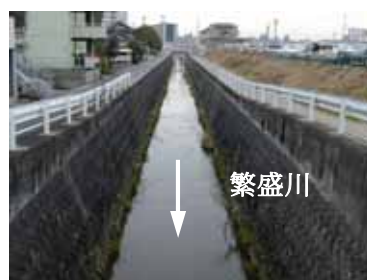
写真－ 11 繁盛川 (繁盛橋 0.4km 付近)
