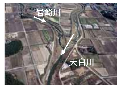
写真－ 2 天白川 （岩崎川合流点 16.8km 付近）
