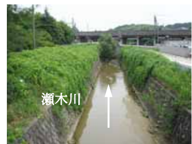
写真－ 8 瀬木川 (瀬木橋 0.1km 付近)
