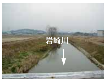
写真－ 12 岩崎川 (昭和橋 0.4km 付近)
