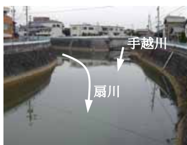
写真－ 5 扇川 （手越川合流点 4.5km 付近）
