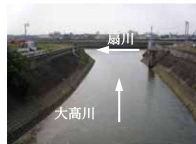
写真－ 7 大高川 (扇川合流部 0.0km 付近)
