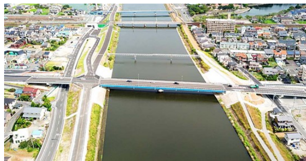
写真－22 日光川 国道一号日光大橋
