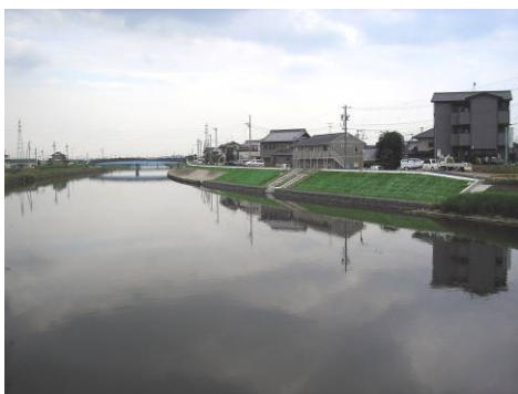
写真－21 近年の日光川本川の築堤・護岸工事
