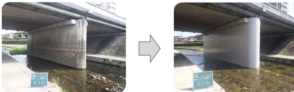
橋桁が落ちないようにする対策
