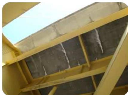
床版の下面の損傷例
