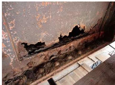
鋼製橋脚の腐食
