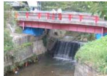
写真-1.9 猿投橋と落差工
