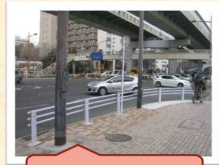
ガードパイプ設置後
