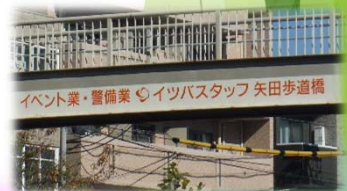
矢田五交差点にある 矢田歩道橋です。
