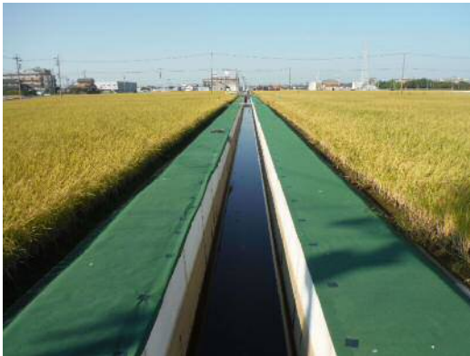
水路の寿命を延ばす補修（港区）
