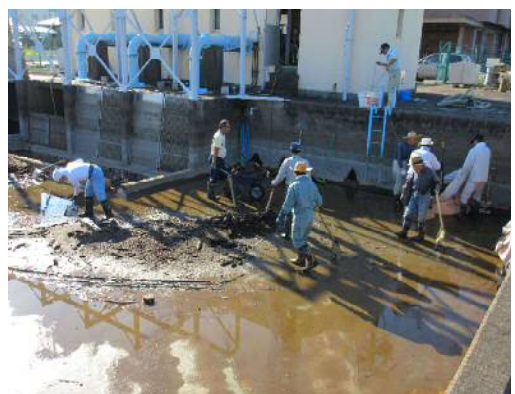
排水機場のしゅんせつ作業（港区）
