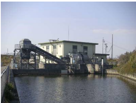
排水機場（港区）
