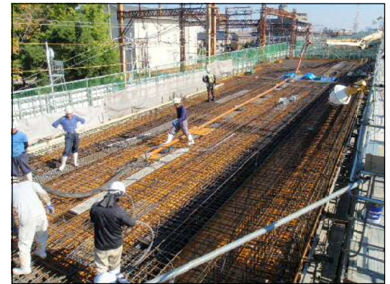
高架橋本体工事中
