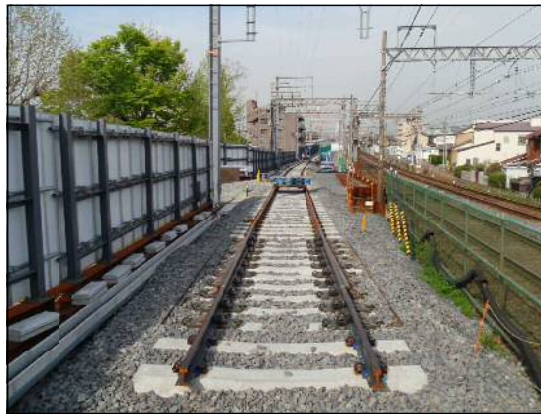
仮線路（名古屋方面）工事中
