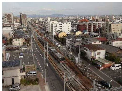
②上り仮線切替完了（平成30年3月）
