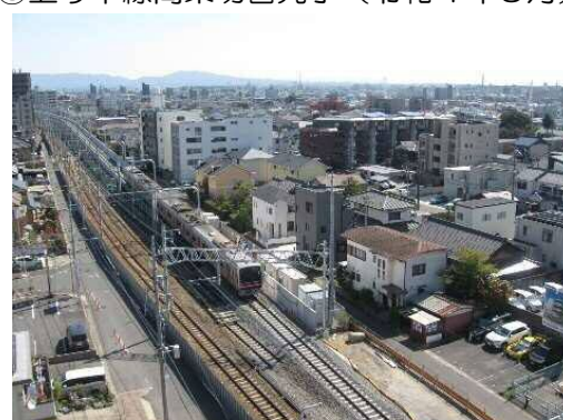
③上り本線高架切替完了（令和4年3月）
