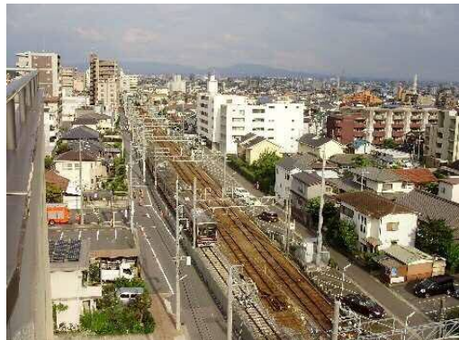
①下り仮線切替完了（平成28年9月）
