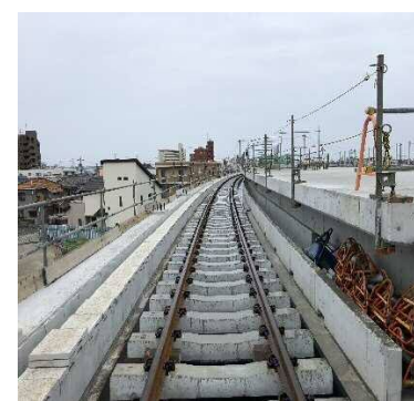
参考写真（軌道）
