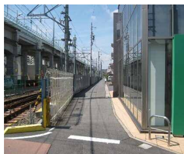
現況の仮側道
