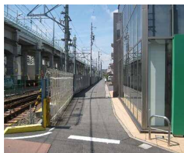
現況の仮側道
