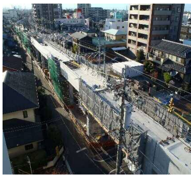
参考写真（柱・床版）
