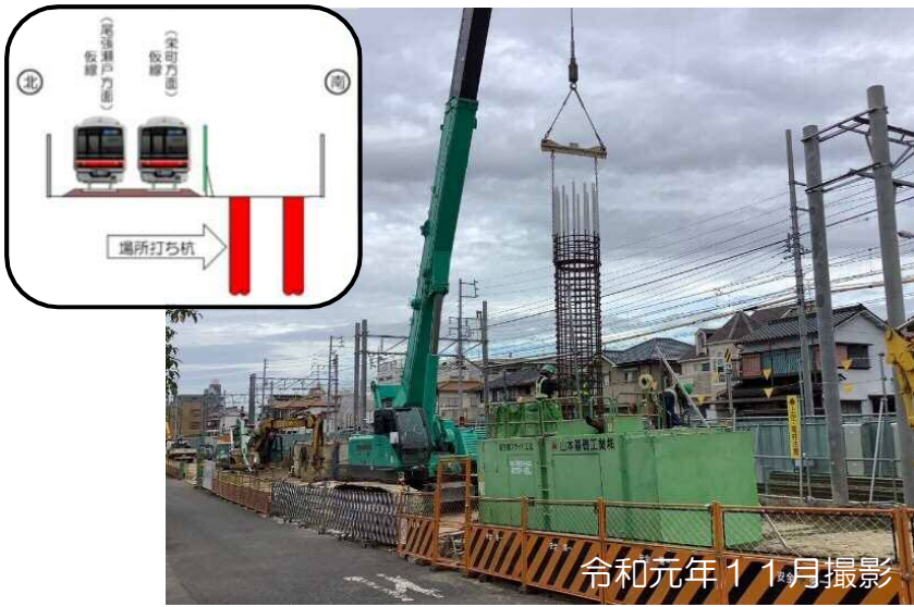
基礎杭施工状況
