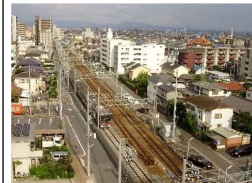
①下り仮線切替完了 （平成28年9月）
