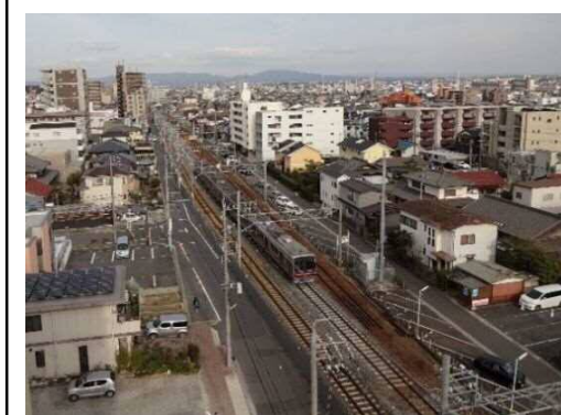
②上り仮線切替完了 （平成30年3月）
