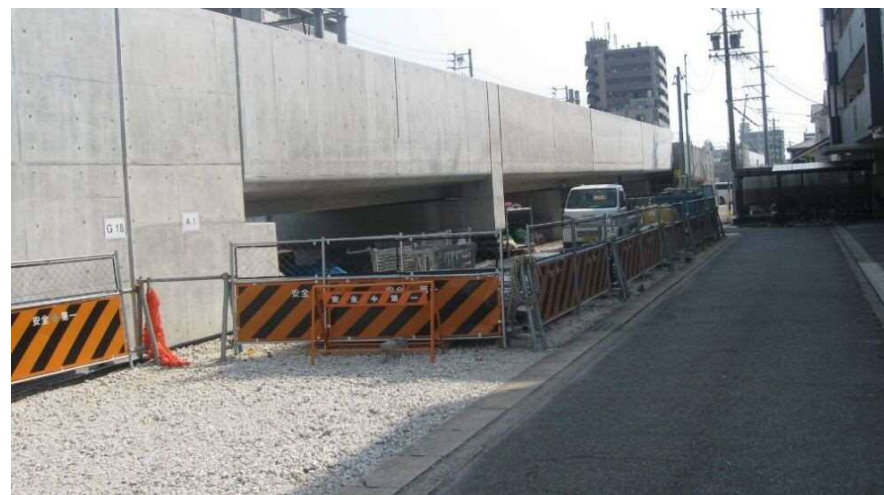
②小幡3号踏切部（人道踏切）工事状況
