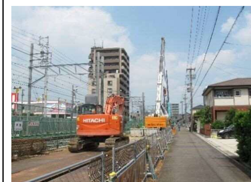
③上り本線高架橋本体工事着手 （平成30年8月）
