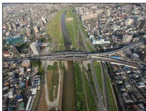
三階橋（整備後）
