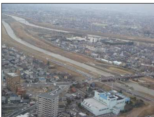
三階橋（整備前）
