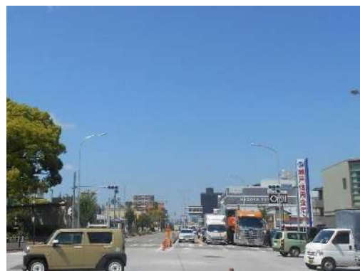
名古屋環状線（整備後）
