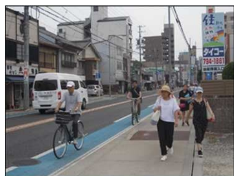
県道名古屋瀬戸線（整備後）
