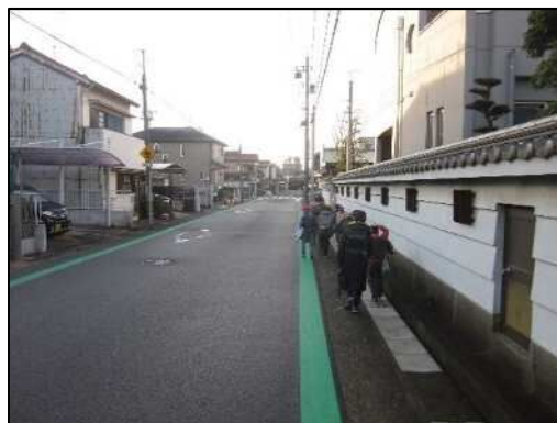
平田小学校（整備後）
