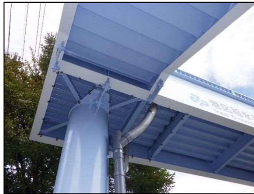
西稲永荘前横断歩道橋（修繕後）
