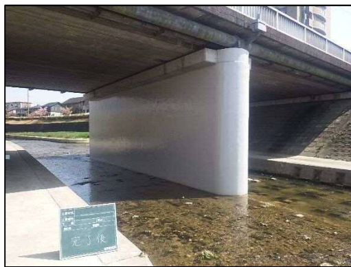
新藤森橋（整備後）
