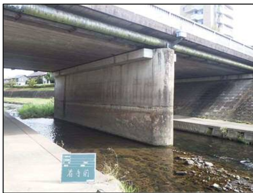
新藤森橋（整備前）
