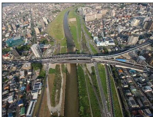
三階橋（整備後）
