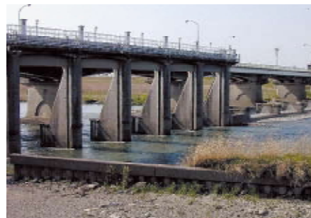
■庄内用水頭首工 堀川の上流端。庄内川の水を頭首工でせき止め元杖樋門から通水。
