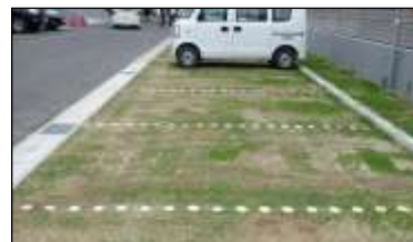
ラインマーカーの設置により 面的な路盤転圧が可能
