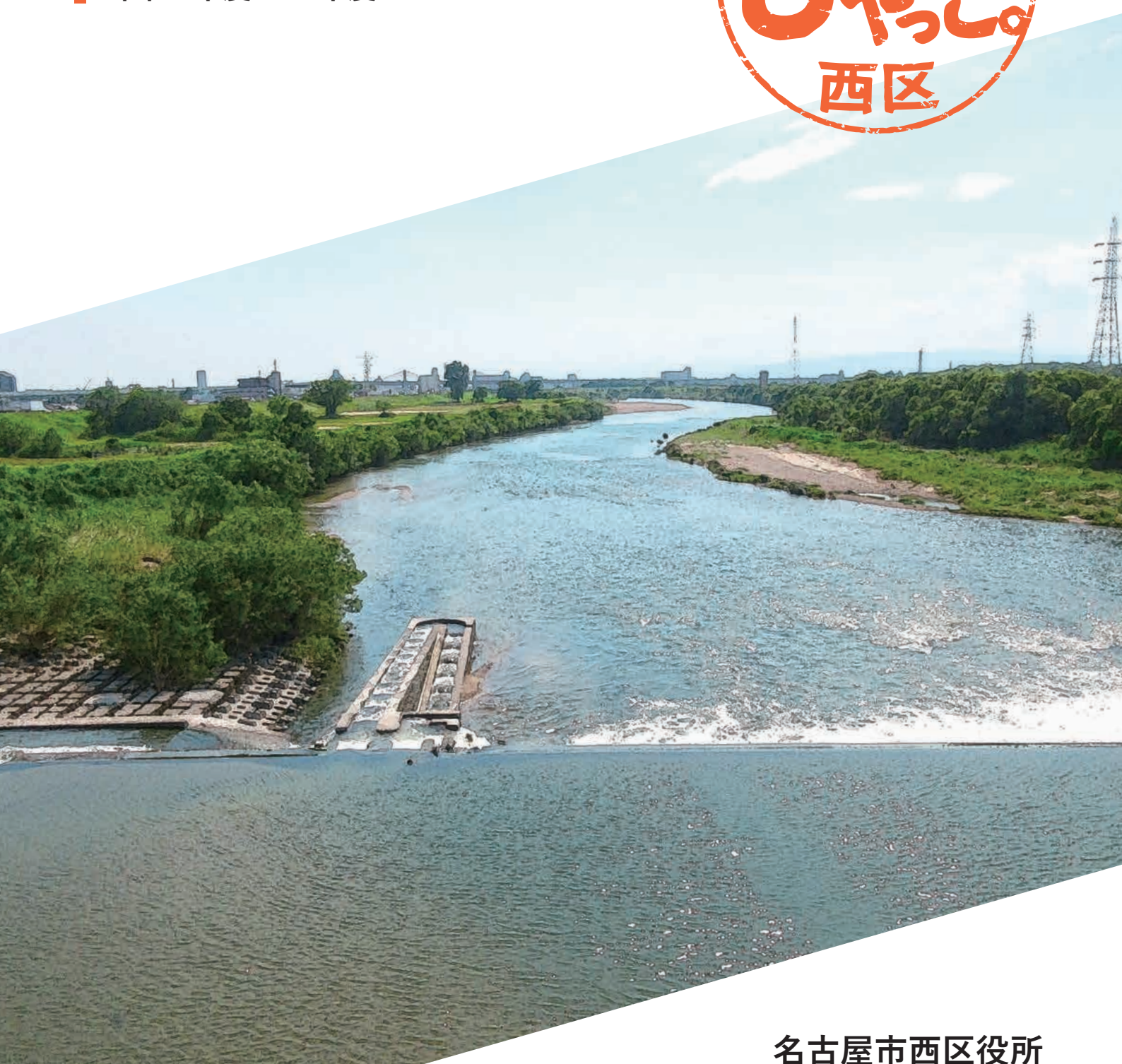
▲庄内川橋から庄内川の下流を望む
