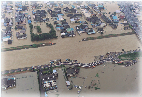
堤防決壊箇所の様子（提供：庄内川河川事務所）
