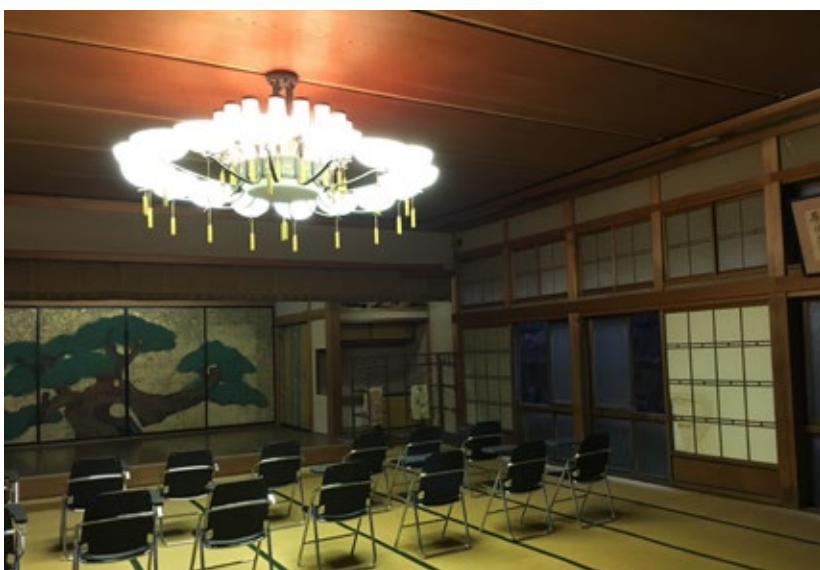
宴会場の天井の板は、樺の一枚板になっている。 このような一枚板を使用した建物は建設当時は珍しかった。
