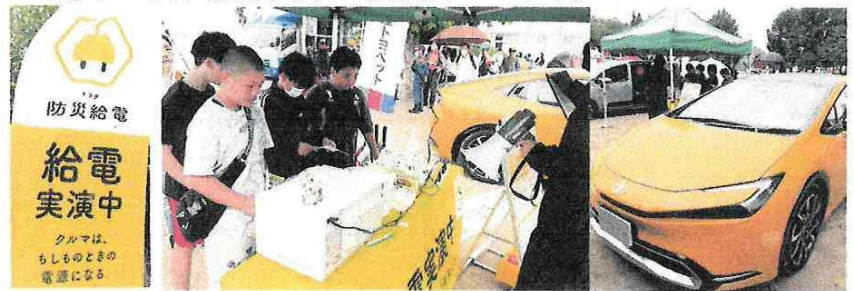
■ 電源車から給電実演 (NTP名古屋トヨペット)
