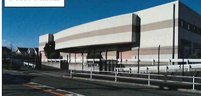
戸田ポンプ所外観
