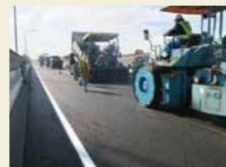
高機能舗装への打ち換え
