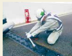
伸縮装置の取り替え
