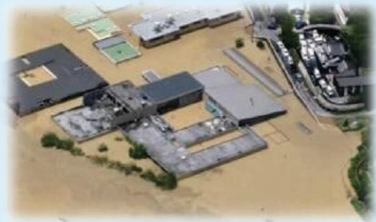
令和2年7月の球磨川流域の豪雨により、浸水した要配慮者利用施設
