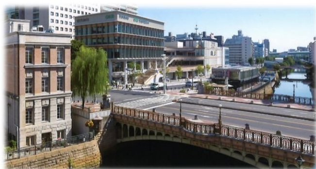
堀川（旧加藤商会ビルと納屋橋）
