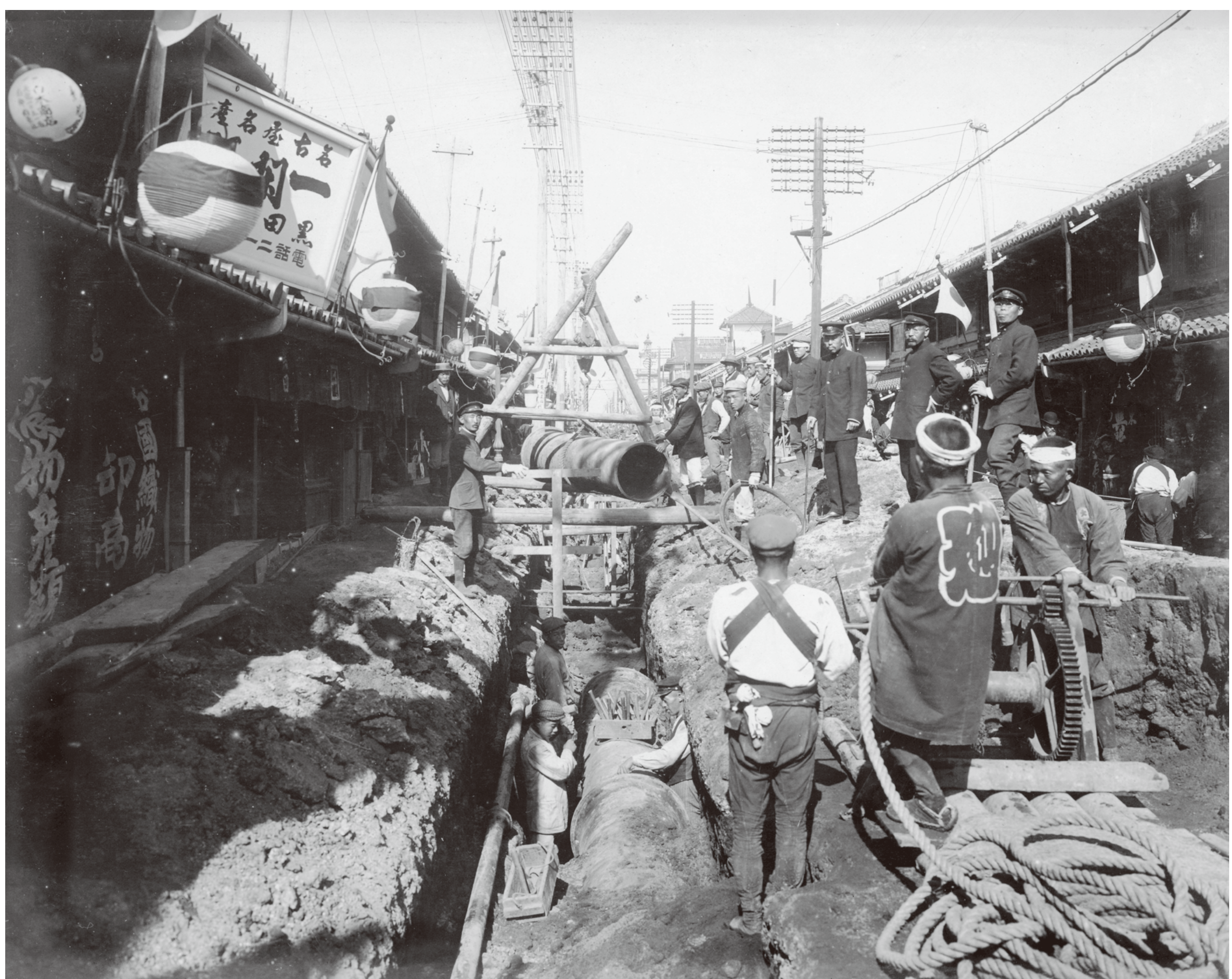
▶鉄砲町での配水管布設の様子。 ちようちゃんに黒い帯が巻かれていることから、 明治天皇崩御の直後と推察できる。 (写真提供 名古屋市上下水道局)
