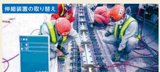
古くなったゴム製の伸縮装置を安全性、快適性向上のため取り替え工事を行います。
