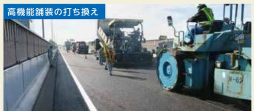
高機能舗装の打ち換えや、施設等の補修工事を行います。併せて大規模修繕工事(防水層の設置)を行い、構造物の長寿命化を図ります。
