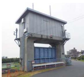
洪水時における矢田川から守山川への逆流防止を目的に昭和47(1972)年3月に建設された。瀬古水位観測所で監視し、遠隔操作により制御される。守山川は古くは大川と呼ばれた自然河川で、耕地整理に伴い改修された。
