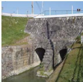
明治の初め、犬山～名古屋間の物流と農業用水を目的とした河川が必要になりました。明治10(1877)年水分橋から矢田川の伏越間で完成するも腐朽が目立ち、明治43(1910)年に現在のアーチ型水門(長さ30m、幅2m、高さ3m)が改築されました。人造石(たたき)工法の護岸等と通船鎖跡があります。
