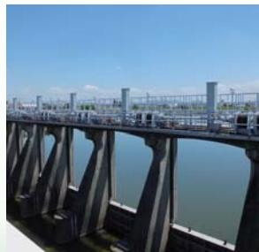
庄内川の水位を上げ、元杅樋門に注水する施設(堰)です。明治10(1877)年黒川開削の際の木柵と石積の仮堰設置が始まります。毎年通水期間中だけ仮堰を造り、洪水時に堰が破損・流出する都度補修を繰り返していました。昭和29(1954)年に現在の形となりました。
