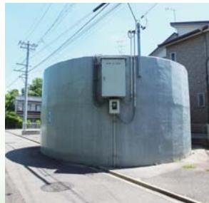
昭和22(1947)年の大干ばつで水不足となった庄内用水の水量確保のために、翌年に瀬古地区に巨大な井戸が作されました。直径6m、深さ8m、井筒高は3mです。昭和27(1952)年に使用を休止しましたが、堀川の水量確保のため平成13(2001)年に給水を再開しました。
