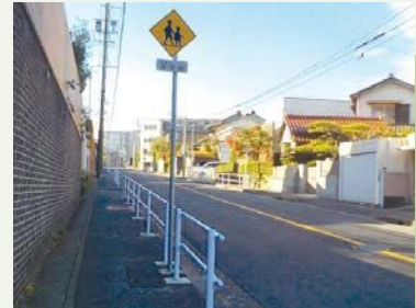
交通安全施設の設置
