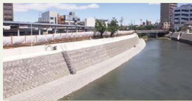
山崎川堤防の改修
