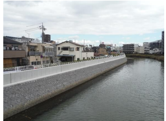
耐震強化後の堤防（土市町）
