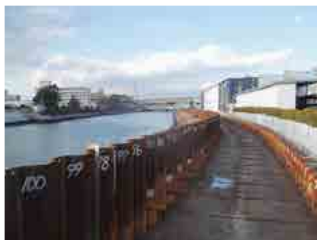
図 4.2 河川堤防の耐震対策（山崎川）
