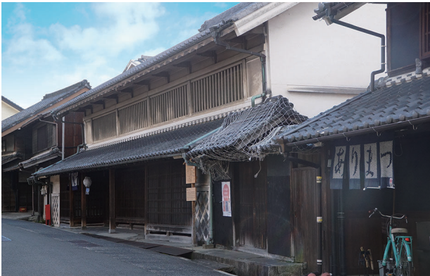
岡家住宅(名古屋市指定文化財・都市景観重要建築物)
