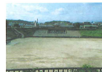
4 扇川公園 (雨水調節池)
