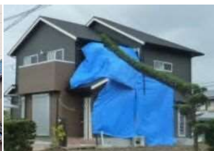
一部損壊 損害割合20%未満
