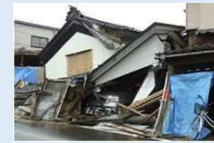
住宅被害の一例
