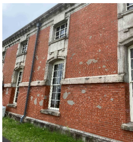
砲弾跡の残る 鍋屋上野浄水場旧第一ポンプ所
