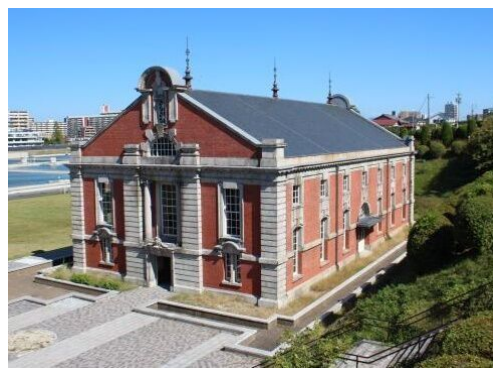
鍋屋上野浄水場旧第一ポンプ所
