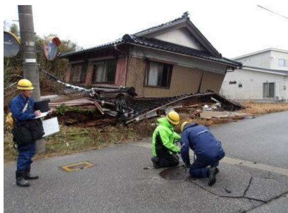
マンホールをあけて下水管を調査
