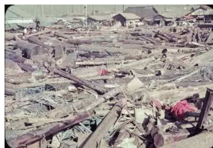
&lt;住宅を押し潰した流木 南区白水町付近 昭和34年&gt;
